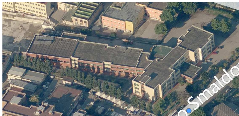
Vista Satellitare - Lato Sud
