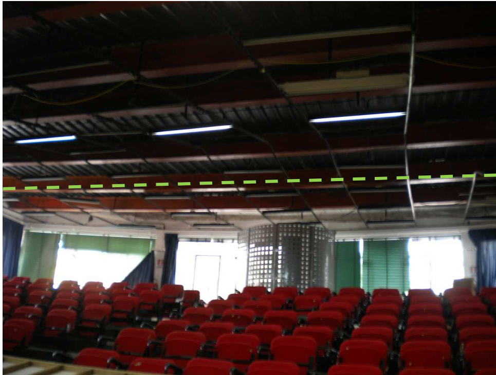
Imbarcamento delle travi d'acciaio di copertura dell'auditorium
