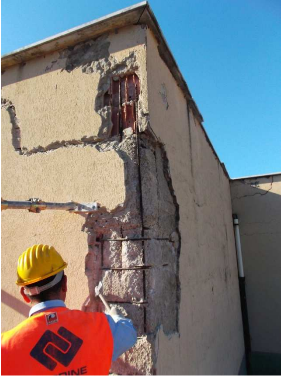
Spicconatura pilastro 7A
