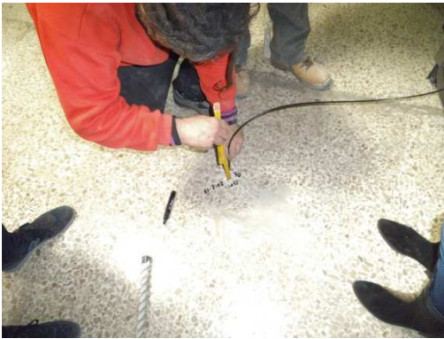
Indagine endoscopica solaio primo impalcato ISP 02
