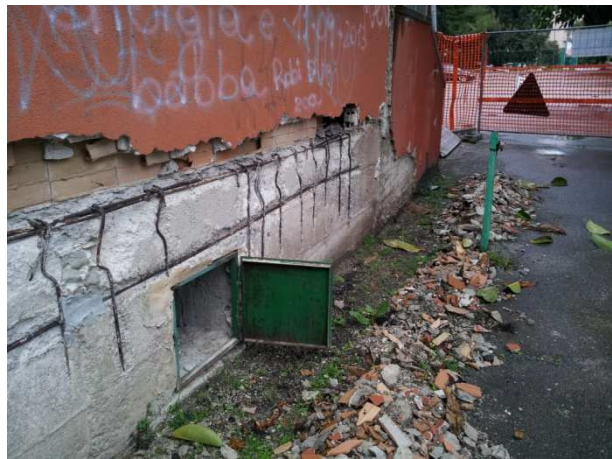
Spicconatura trave di fondazione trave 15 A-29 A
