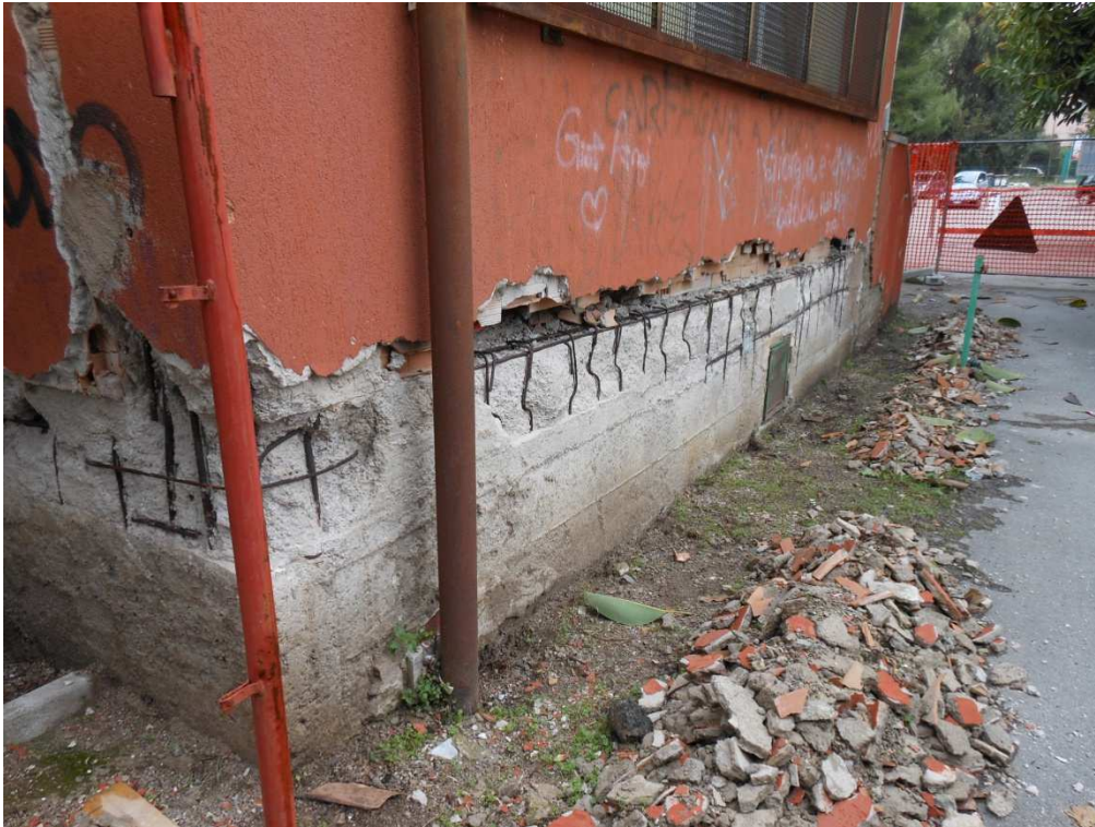
Spicconatura trave di fondazione 15 A-29 A e nodo pilastro 15 A
