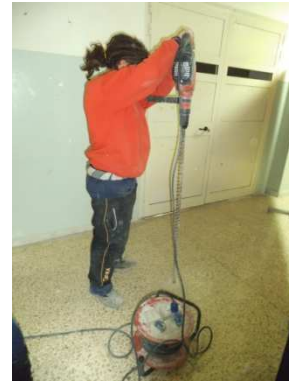
Indagine endoscopica solaio primo impalcato ISP 01
