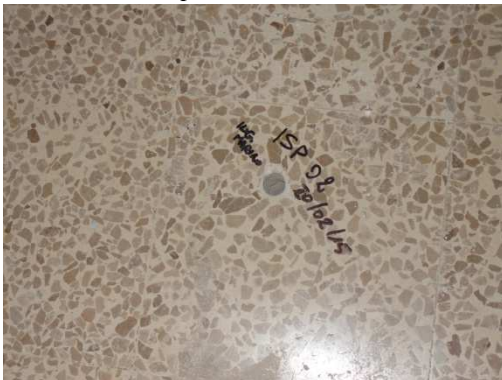
Indagine endoscopica solaio primo impalcato ISP 01
